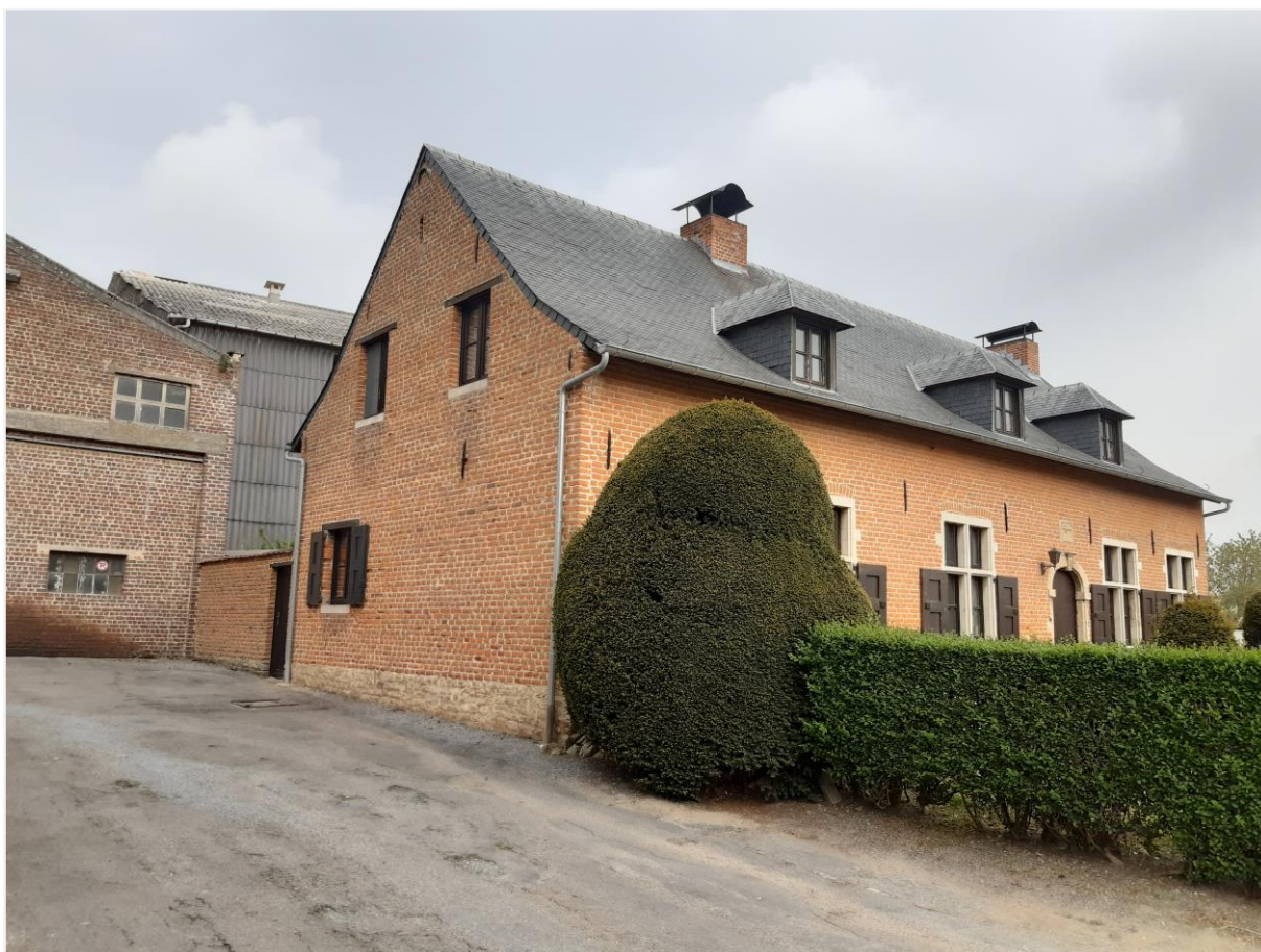
Foto 2: Zuidwestelijke zijpuntgevel met aangepaste vensteropeningen.
