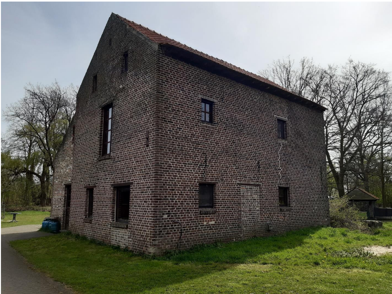
Foto 4: noord- en westgevel van de watermolen.
