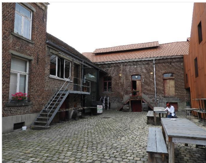
Foto 9: De hoek van het kantoorgebouw en het brouwerijgebouw, erfzijde (09.09.2019).
