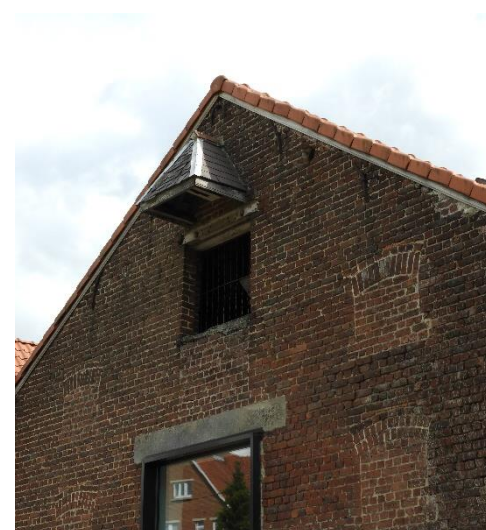
Foto 6: Laadvenster met luikap in topgevel brouwerijgebouw aan de zijde van de Schaveystraat (06.10.2021).
