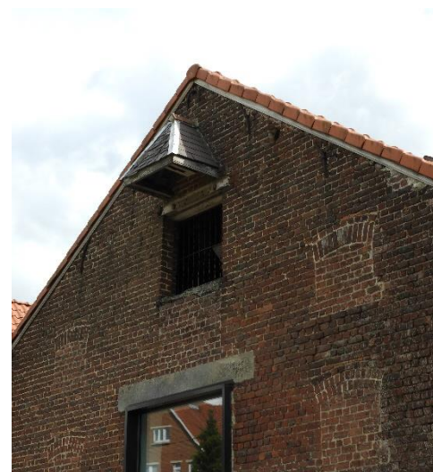
Foto 6: Laadvenster met luik in topgevel brouwerijgebouw aan de zijde van de Schaveystraat (06.10.2021).
