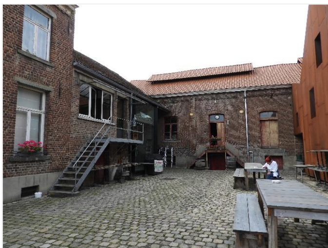
Foto 9: De hoek van het kantoorgebouw en het brouwerijgebouw, erfzijde (09.09.2019).
