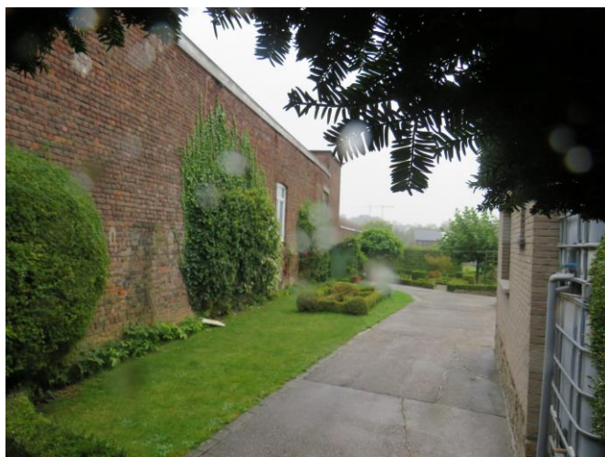
Foto 7: Het brouwerijgebouw, westgevel (06.10.2021)
