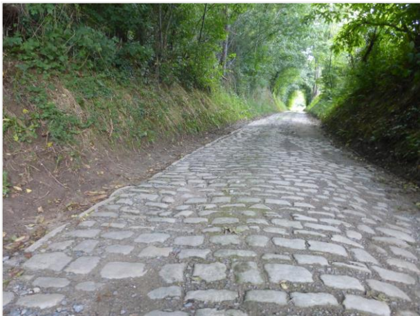
Foto 7: Licht bolrond wegprofiel in de holle weg.
