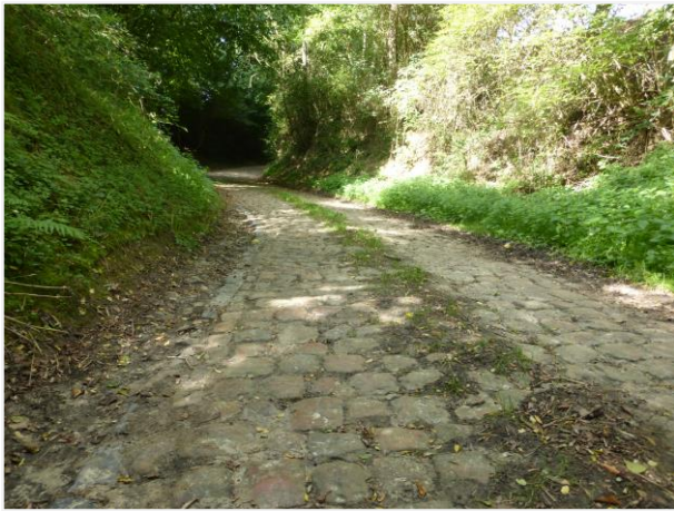
Foto 9: Dubbele rij boordstenen in Petit Granit en Tiense kwartsiet in de holle weg.
