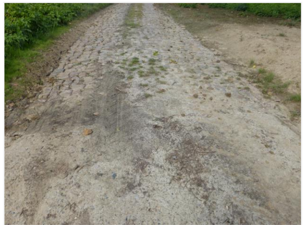
Foto 4: Zone met betonverharding ter versteviging in de bocht.
