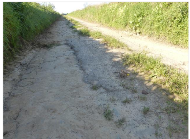
Foto 6: Zone met asfaltverharding halverwege.
