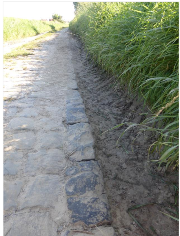
Foto 4: Spoorvorming langs de boordstenen in de holle weg.
