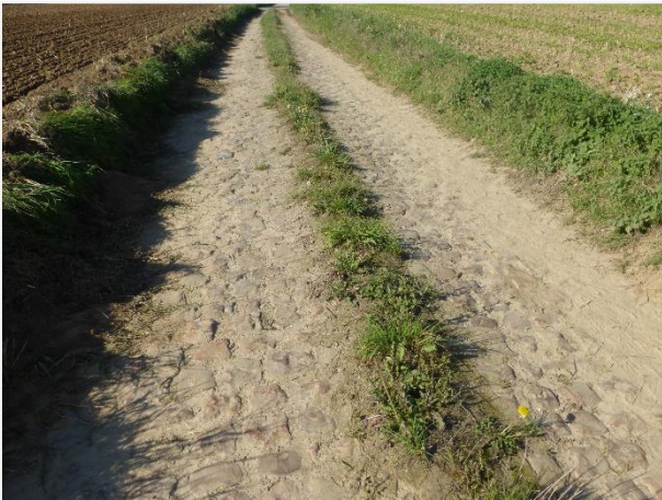
Foto 9: Gemengde kasseiverharding in het zuidwesten van het wegtracé.
