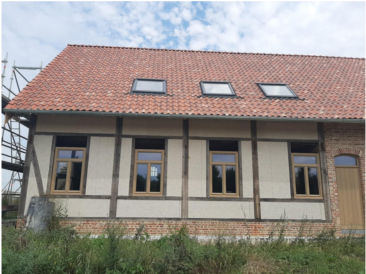
Foto 5: Gereconstrueerde en verplaatst vakwerkgedeelte van het woonhuis.
