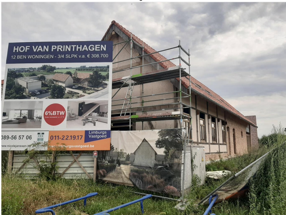
Foto 2: Woonhuis van de vakwerkhoeve parallel met de Hasseltsesteenweg.
