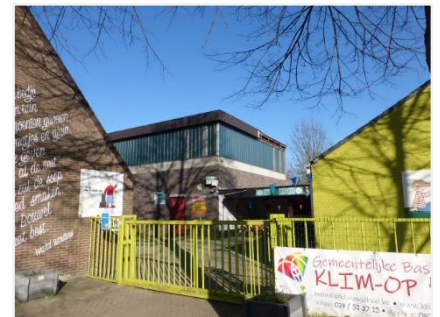
Foto 12: Schoolgebouwen ten noordoosten van de kerk.
