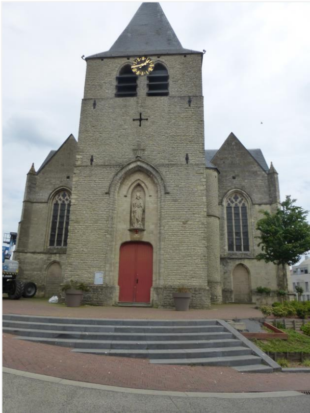
Foto 1: Sint-Servatiuskerk: westtoren met toegang.
