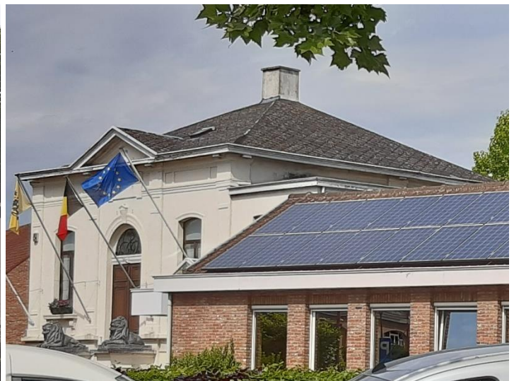
Foto 4: voorgevel en bedaking.
