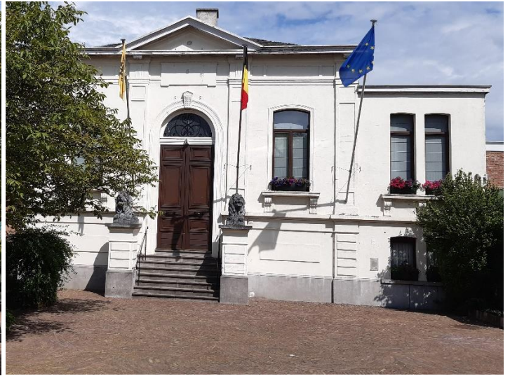
Foto 2: voorgevel en oostelijke aanbouw.
