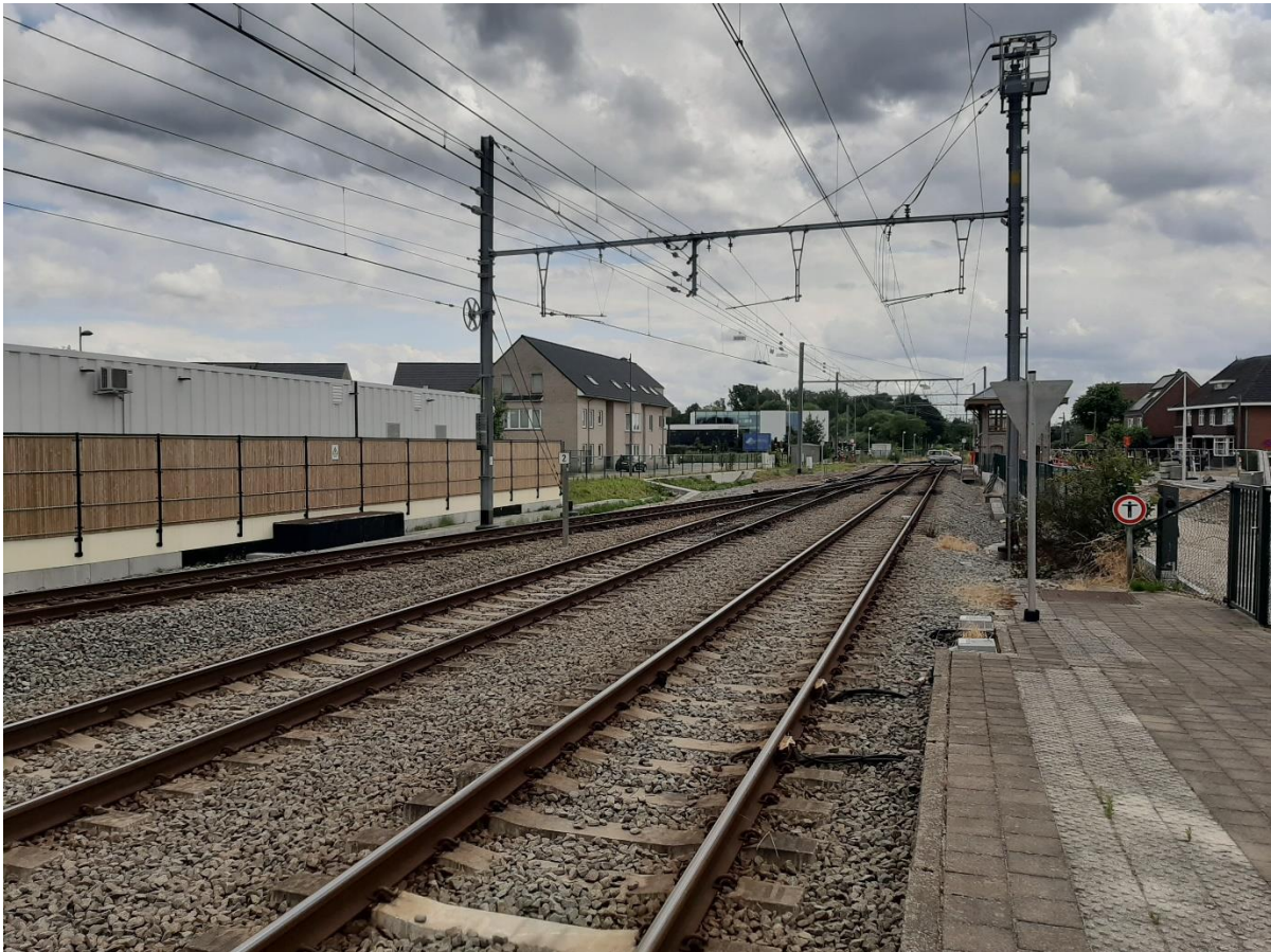
Foto 5 - Zicht op het spoor in zuidelijke richting waar de wisselhendel verdween (opname 5 juli 2023) (© Onroerend Erfgoed – Annelien Sys).
