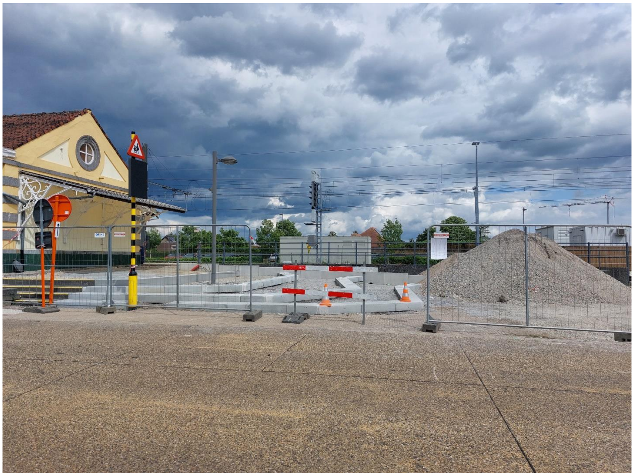
Foto 3 – Zicht vanuit het westen op de ruimte rechts van het stationsgebouw waar tot 1995 de lampisterie stond (opname 5 juli 2023) (© Onroerend Erfgoed – Katrien Verwinnen).
