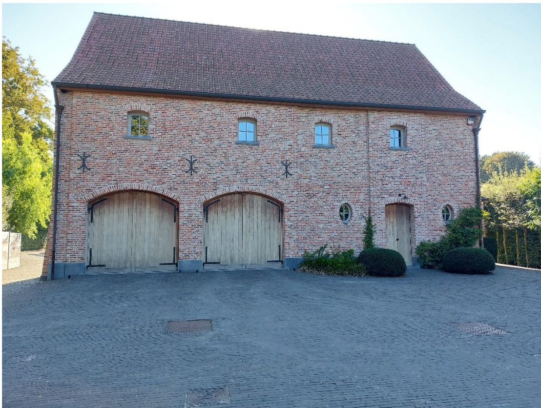
Foto 1: oprit en voorgevel van de nieuwbouwwoning Steenweg van Aalst 118A
