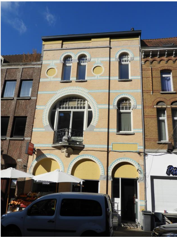
Foto 1: voorgevel, opnamedatum 5 augustus 2022. (copyright Onroerend Erfgoed)
