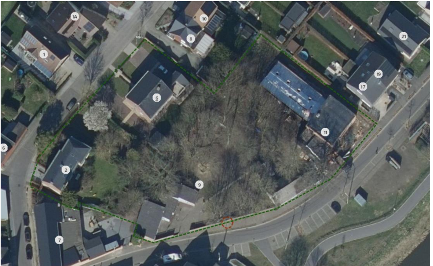
1: Bovenaanzicht van het gedeeltelijk op te heffen beschermd cultuurhistorisch landschap Pastorie Sint-Clemensparochie: tuin met levensboom, meest recente toestand (orthofoto 2022, geraadpleegd op geo.onroerenderfgoed.be op 17 augustus 2023)
