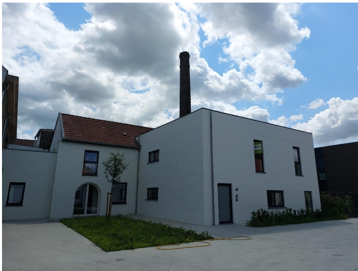
Foto 4 – Het brouwerijgebouw op de binnenkoer (opname 5 juli 2023) (© Onroerend Erfgoed).
