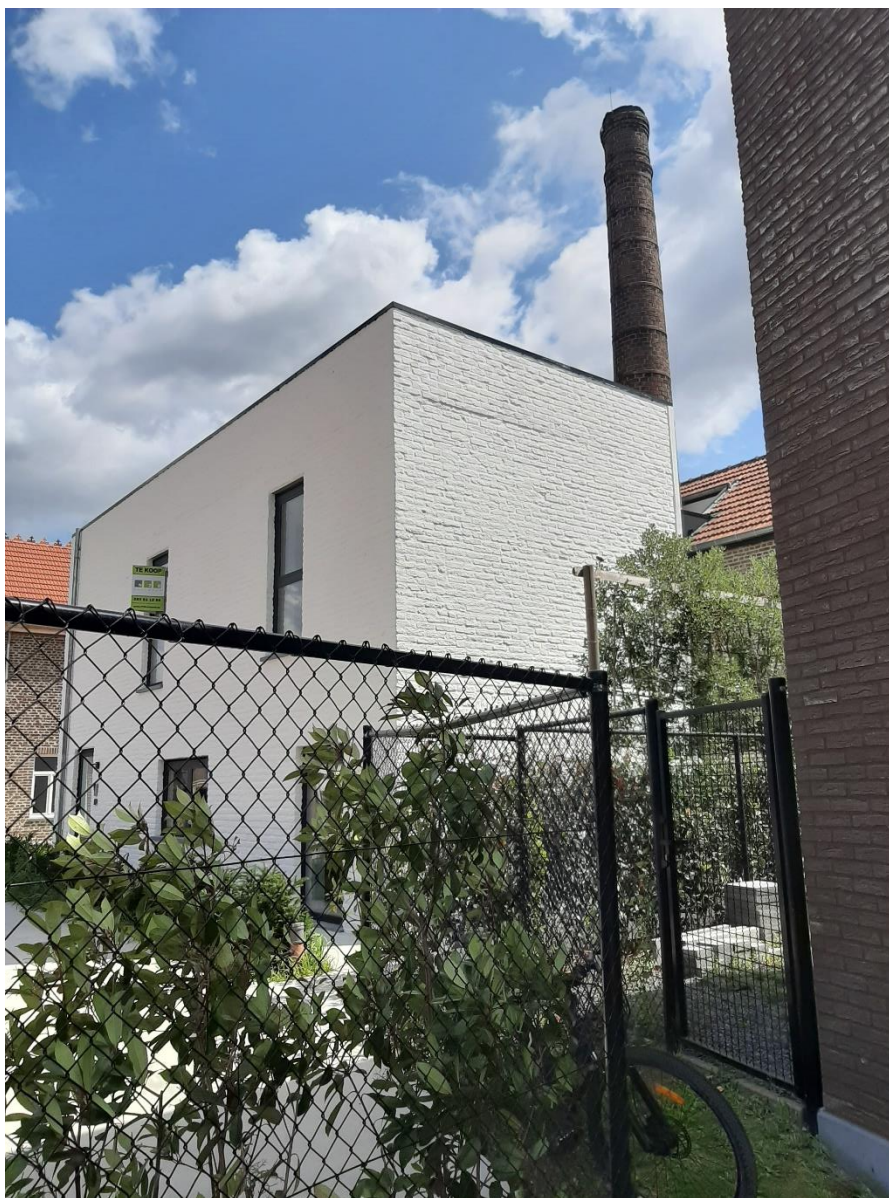
Foto 5 – Het brouwerijgebouw op de binnenkoer (opname 5 juli 2023) (© Onroerend Erfgoed).
