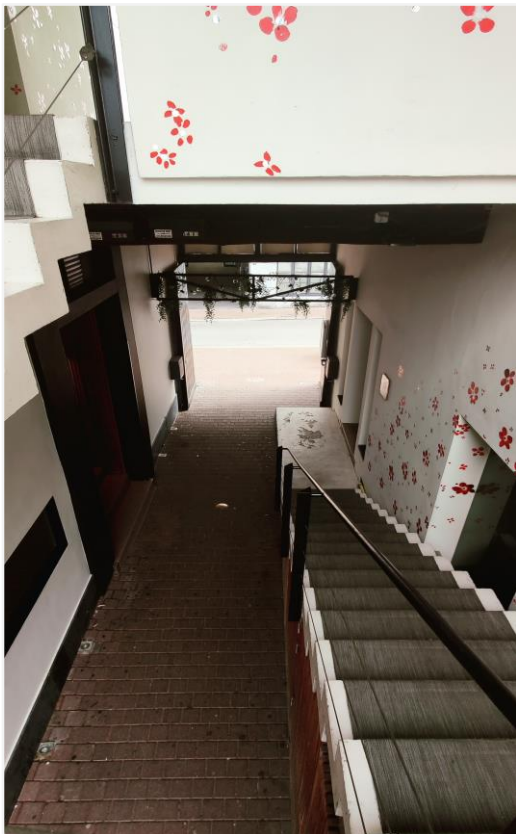
Foto 10: betonnen trapconstructie in poortdoorgang
