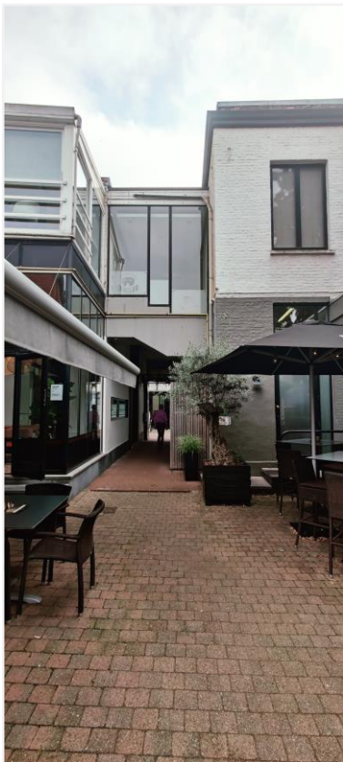
Foto 7: achtergevel met poortdoorgang en traphal erboven
