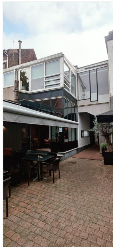
Foto 8: achtergevel met moderne aanbouw
