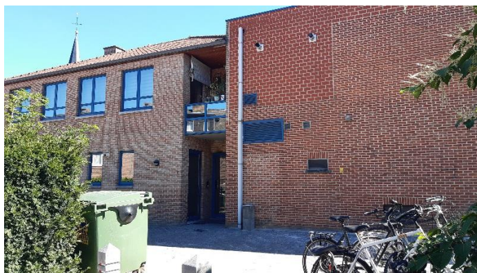
Foto 8: Nieuwe gildezaal en appartementen (zijde Diepstraat) (5 september 2023)
