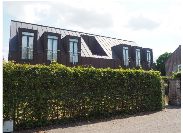
Foto 4. Nieuwbouw tweewoonst op perceel 140K.
