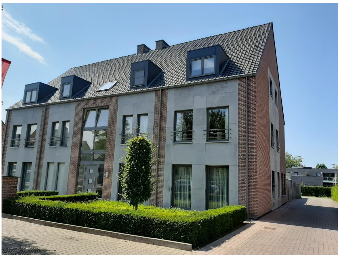
Foto 2. Appartementsgebouw met rechts oprit naar parkeergarages
