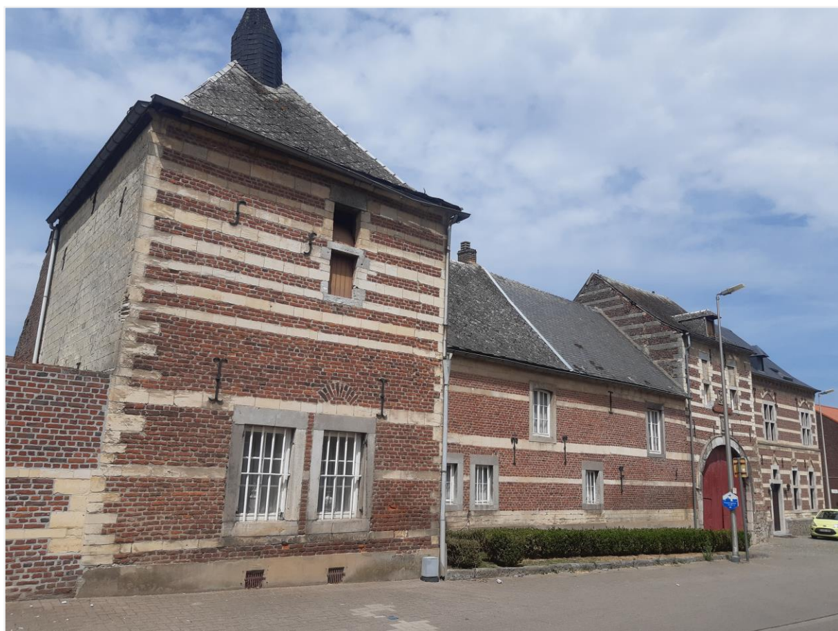
Foto 2: Hof de Méan, Bolderstraat 60-62 – zicht op de hoektoren (voormalige duiventoren), dienstgebouw, poortgebouw en herenhuis (beschermd als monument).
