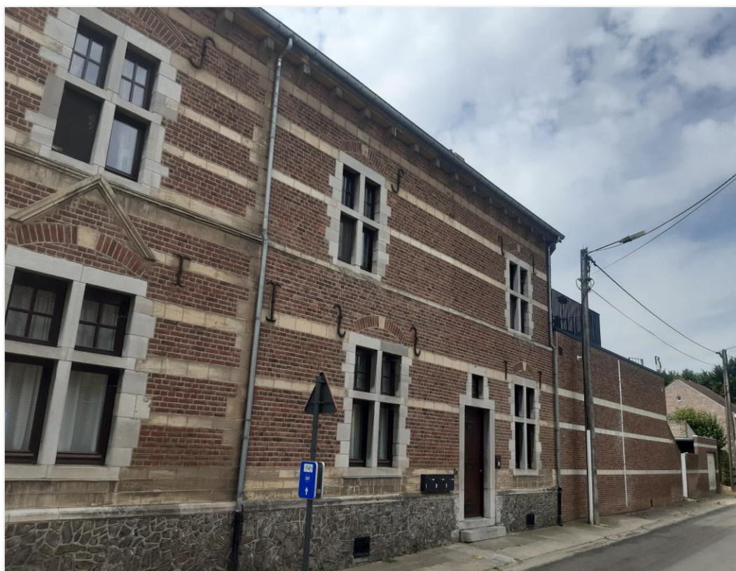
Foto 4: Hof de Méan – De Meanstraat 2A – zicht op straatgevels van het herenhuis de Méan (monument) en de straatmuur (gelegen binnen het op te heffen dorpsgezicht).
