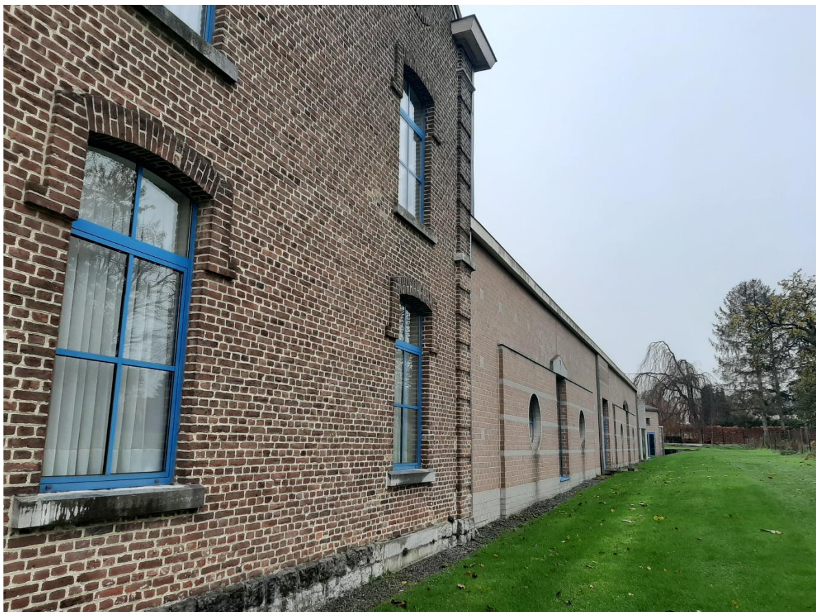
Foto 4: zijgevel van het klooster en schoolgebouw
