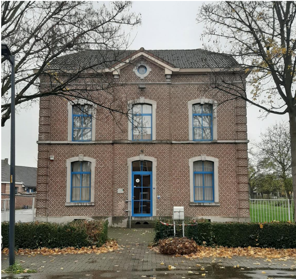
Foto 1: voorgevel van het klooster en schoolgebouw
