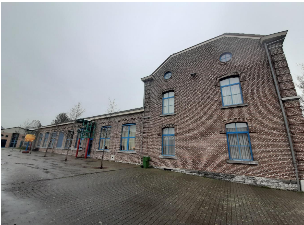
Foto 2: zijgevel van het klooster en schoolgebouw
