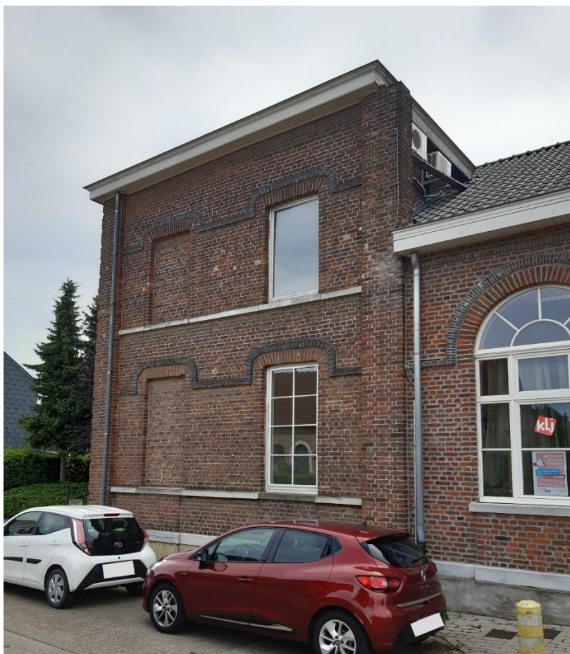
Foto 3: zijgevel van het voormalig gemeentehuis
