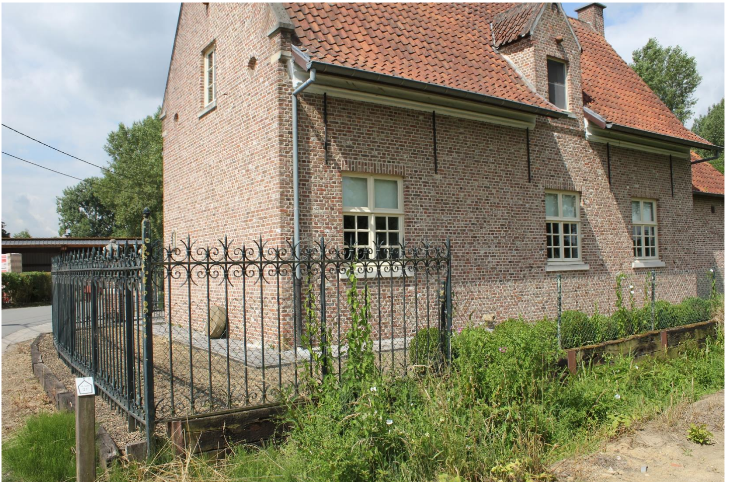
Foto 2: zicht op de achtergevel van het woonhuis van de hoeve
