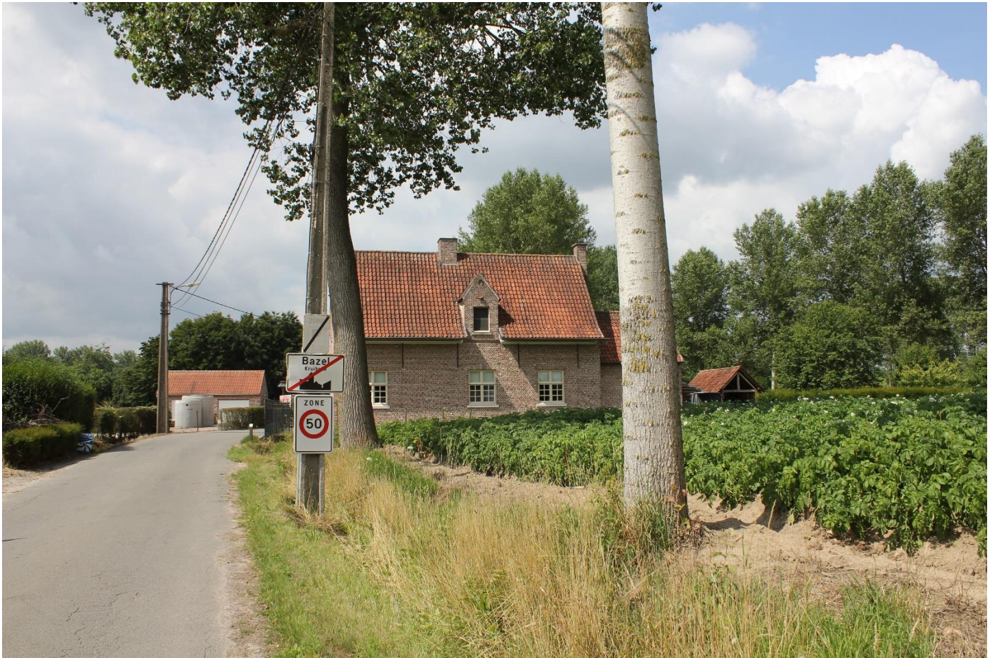
Foto 1: zicht op de achtergevel van het woonhuis van de hoeve
