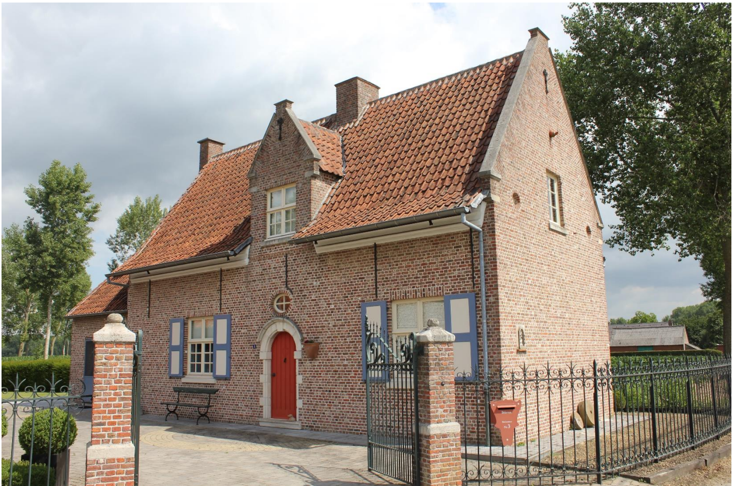
Foto 4: zicht op de voorgevel van het woonhuis van de hoeve
