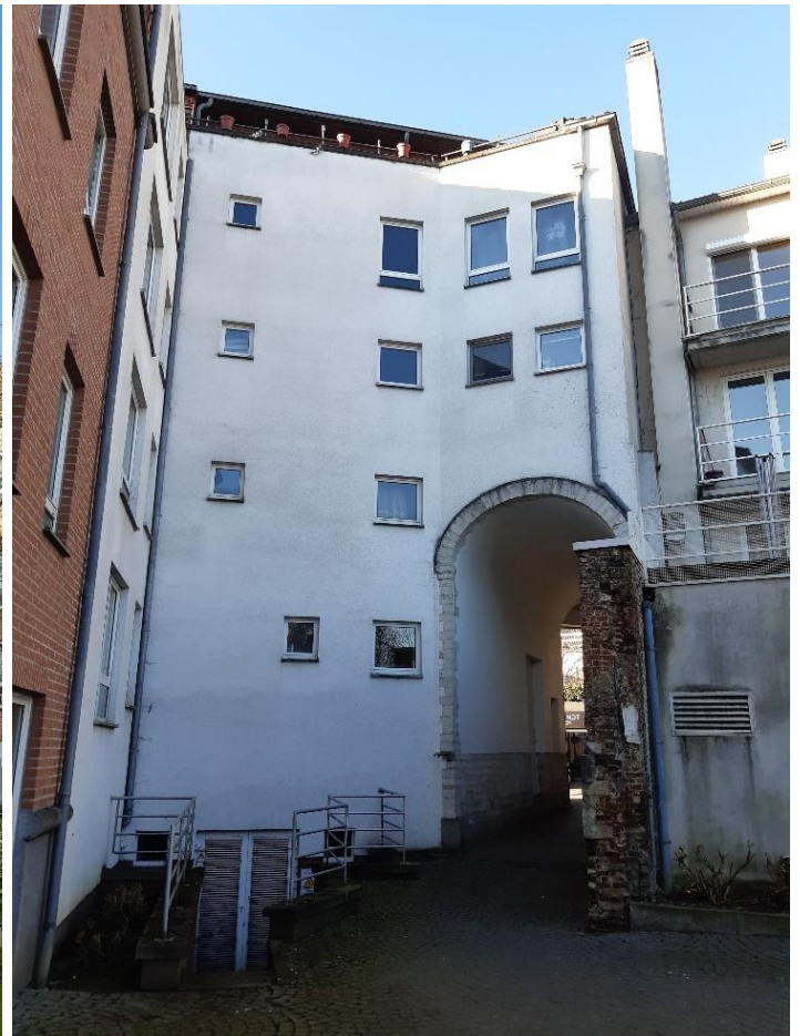
Foto 20: achtergevel van weeshuis met noordelijke doorgang (28 februari 2023).
