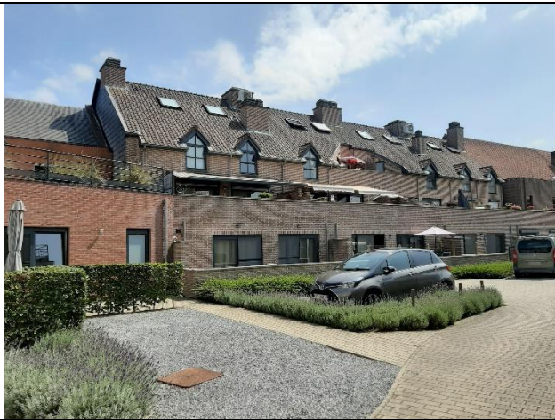
Foto 1: Appartementengebouw en parking
