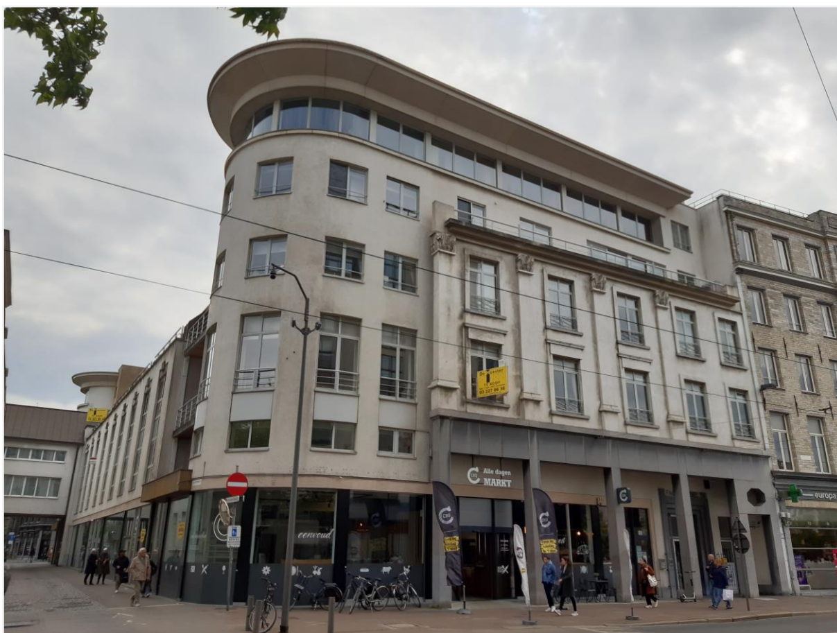
Foto 3: Zicht nieuwbouwcomplex 1992-1994 Groenplaats 40, 40a met geïntegreerd deel noordgevel voormalig Hotel Saint-Antoine (© agentschap Onroerend Erfgoed 30 april 2022)
