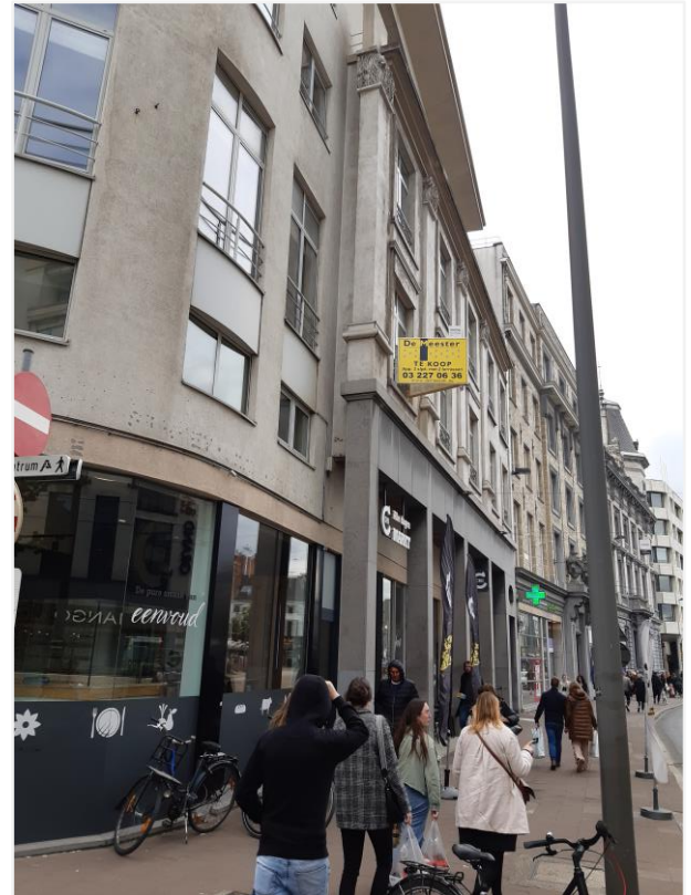
Foto 5: Zijaanzicht geïntegreerd deel noordgevel voormalig Hotel Saint-Antoine Groenplaats 40, 40a (© agentschap Onroerend Erfgoed 30 april 2022)
