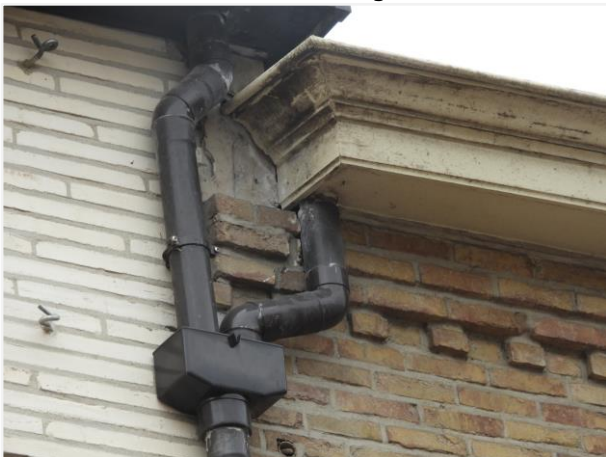
Foto 3: afwerking van het nieuwe gevelparament
