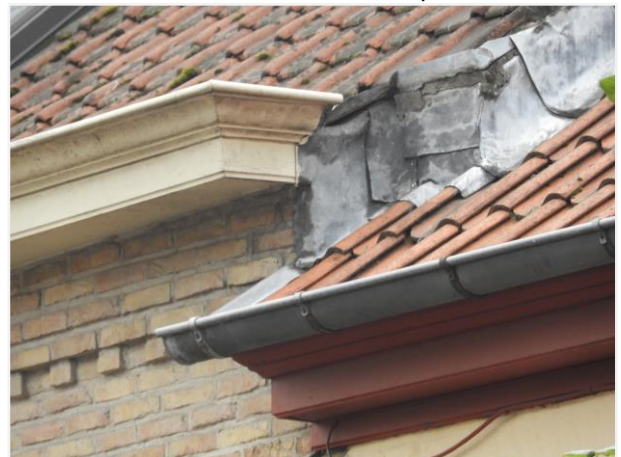
Foto 4: afwerking van het nieuwe gevelparament
