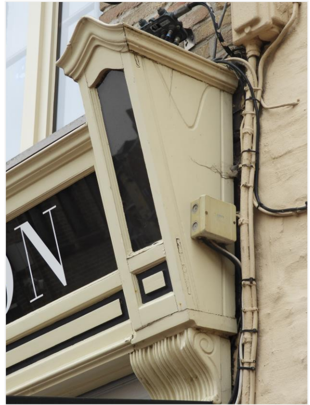
Foto 8: bovenbouw van de winkelpui
