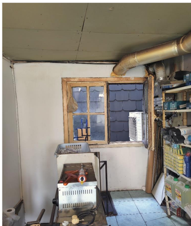
Foto 4: eerste verdieping: zicht naar achtergevel
