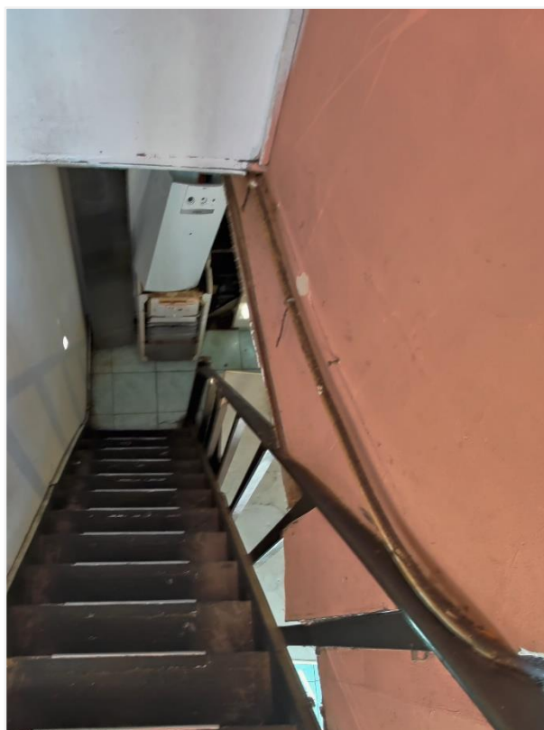
Foto 5: trap tussen eerste en tweede verdieping
