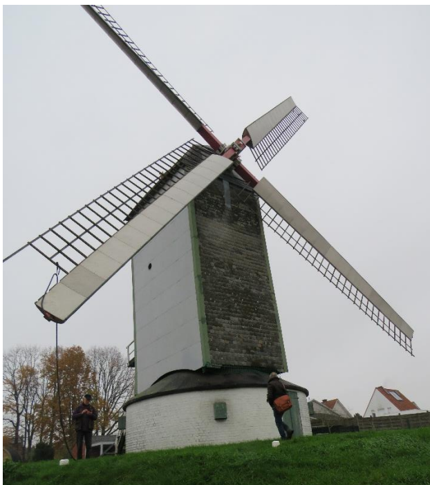
Foto 25 - De Mortiersmolen. Verdekkerd gevlucht.
