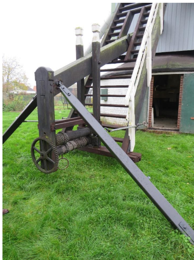
Foto 22 - De Mortiersmolen. Staart met kruitwerk.
