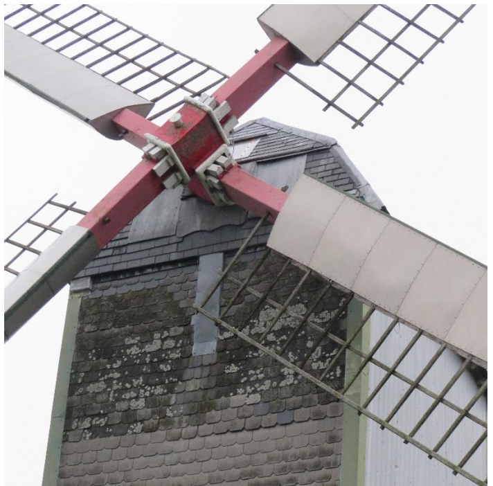
Foto 26 - De Mortiersmolen. Askop met verdekkerd gevlucht.
