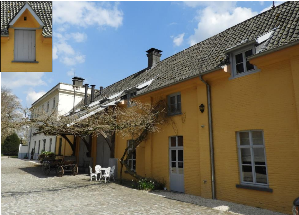
Foto 32: Westelijke aanhorigheid (achtergevel aan diensterv) aansluiting met hogere westelijke zijvleugel en detail laadluikje.
