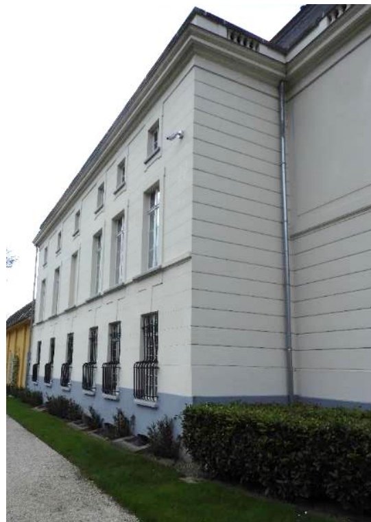
Foto 23: Oostelijke zijvleugel (achtergevel).
