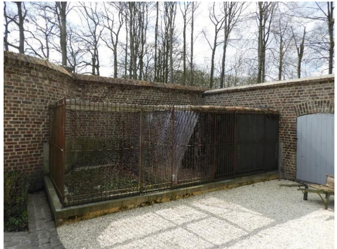
Foto 39: Westelijk dienstterf – hondenhokken, kippenren en afbuigende afsluitmuur.
