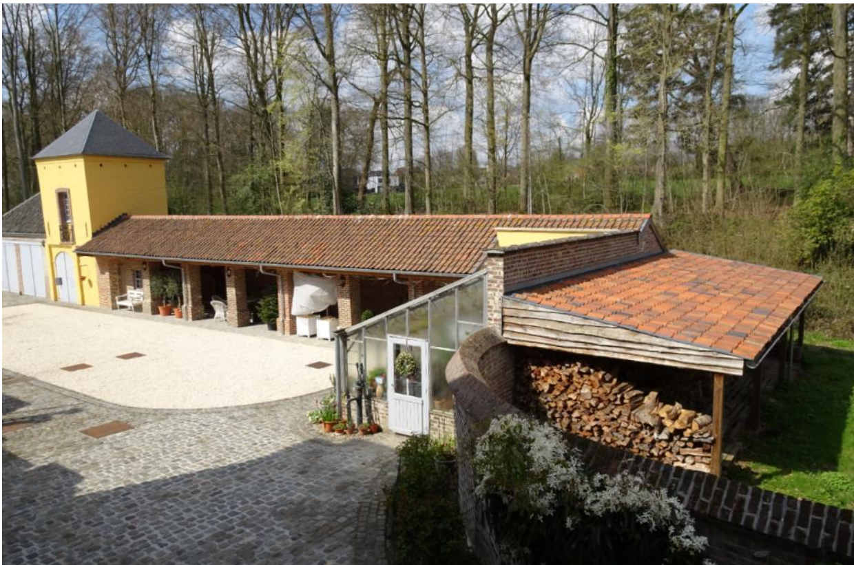
Foto 35: Westelijk verhard dienstert met duiventoren, halfopen gemetste bergplaats, muurserre en afbuigende afsluitmuur.
