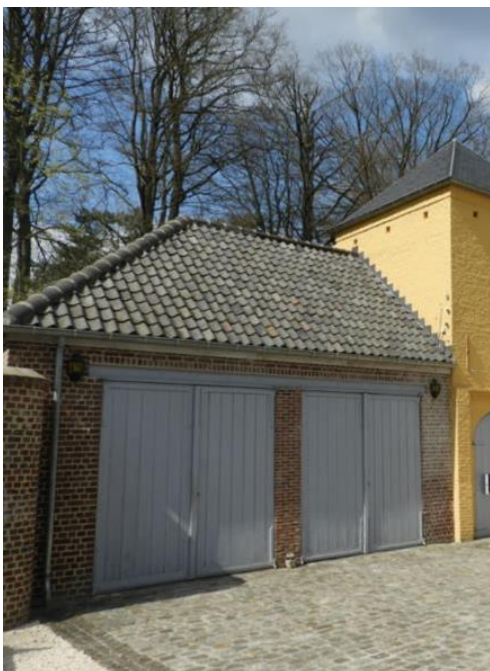
Foto 40: Westelijk dienstterf – garage.
