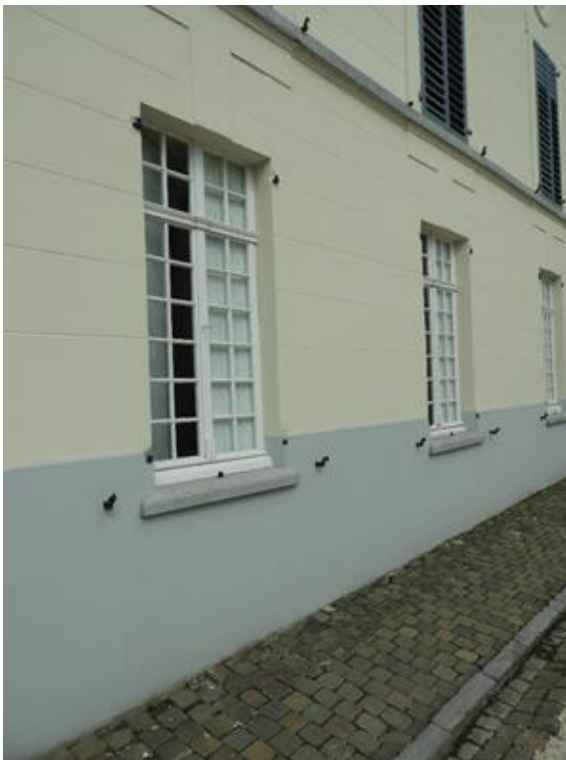
Foto 22: Oostelijke zijvleugel (voorzijde) - detail gevelparament en schrijnwerk.
