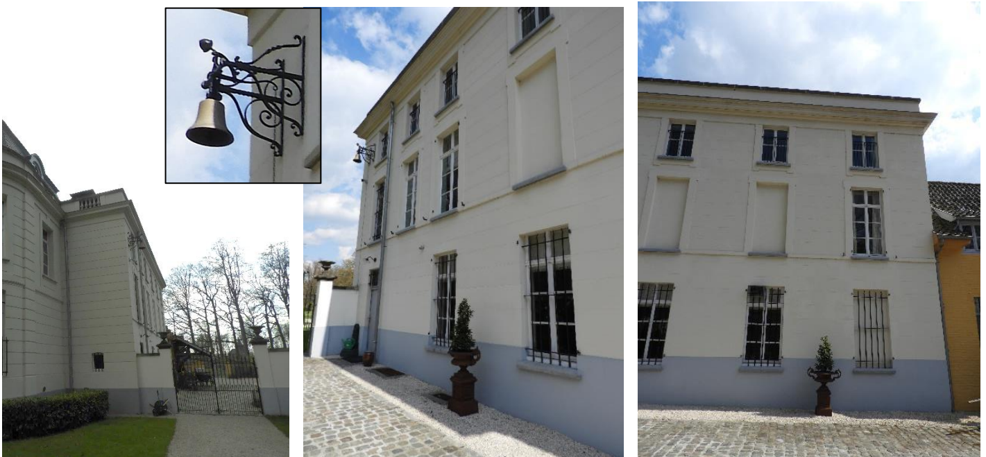
Foto 18: Westelijke zijvleugel (stukje van noordelijke kopgevel) met aansluiting met westelijke halfronde uitbouw.
