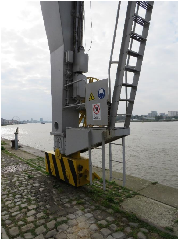
Foto 6: Portaalpoot met bogie en toegangsladder (kaaizijde) (14.10.2021).
