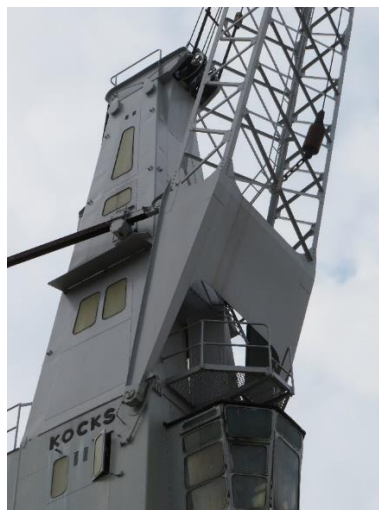
Foto 14: Draaibare bovenbouw met toren en stuurcabine onder de giek (14.10.2021).
