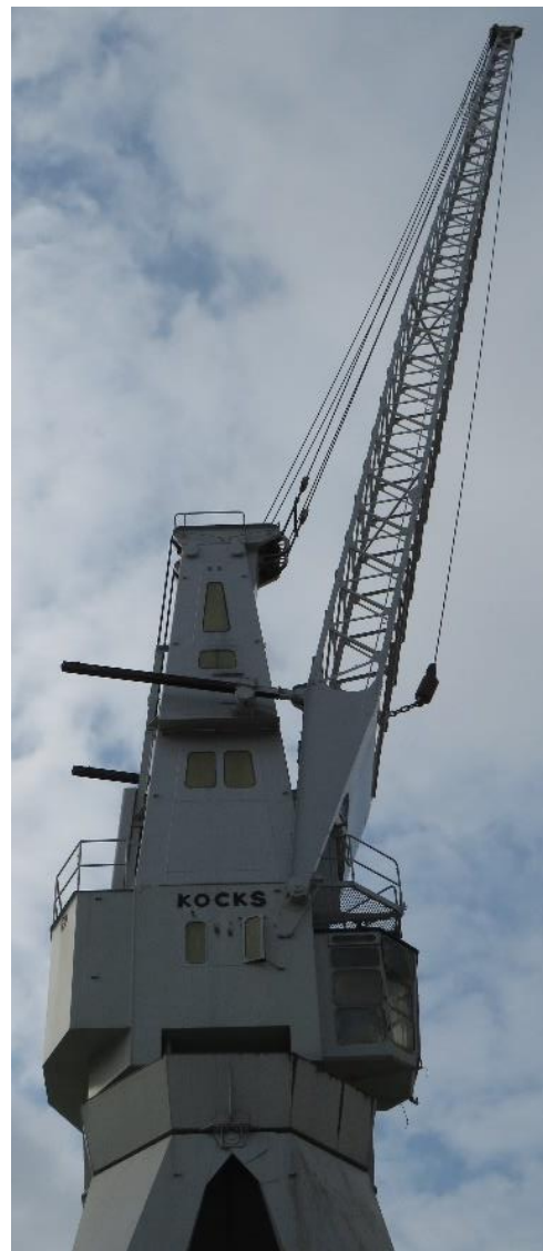
Foto 18: Machinekamer met stuurcabine, toren en giek (14.10.2021).
