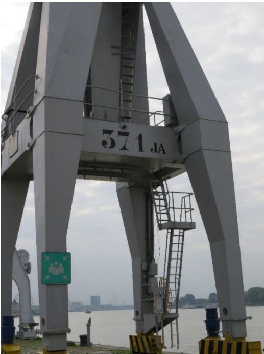
Foto 11: Portaal met toegangstrap (14.10.2021).
