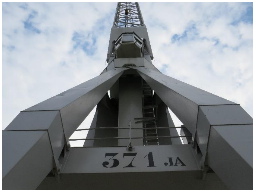
Foto 16: Bovenste deel van het portaal waarin de draibare bovenbouw van de kraan pivoteert (14.10.2021).
