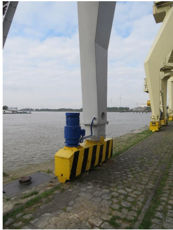
Foto 7: Portaalpoot met bogie met motor (kaaizijde) (14.10.2021).
