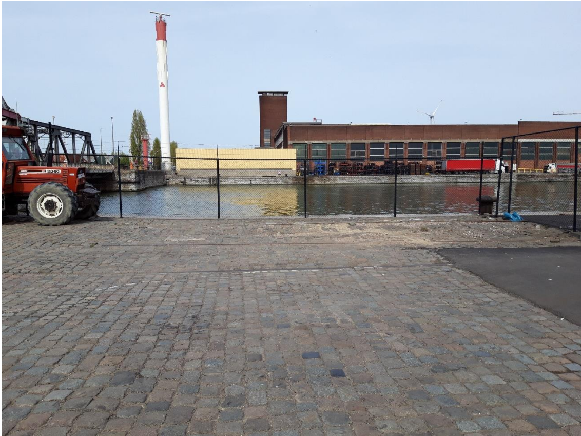
Foto 1: Foto van de deels geasfalteerde, deels gecorrodeerde sporen van de (naar de Rijnkaai overgebrachte) elektrische kraan nr. 371 JA aan de Wijnweg zonder nummer, 12.04.2022 (bron: archief Onroerend Erfgoed, foto genomen door Martijn Kivit)
