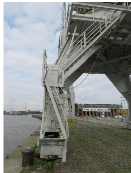
Foto 12: Trap naar de machinekamer (14.10.2021).
