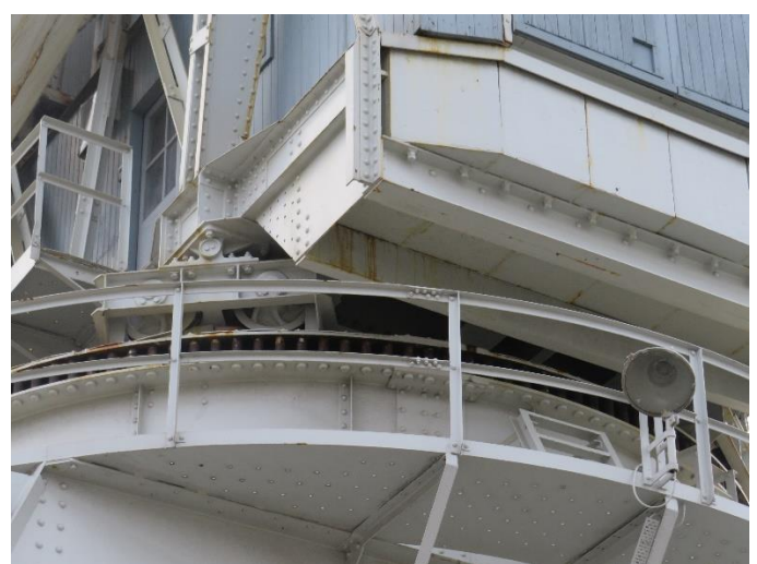
Foto 19: Op koningsas en ringrail draaibare bovenbouw (14.10.2021).
