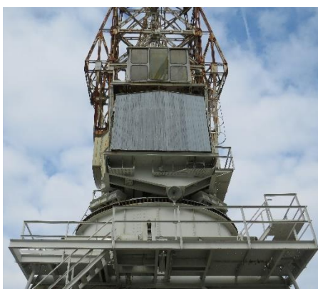
Foto 16: Bordes en tussenbordes met daarop aansluitende machinekamer (14.10.2021).
