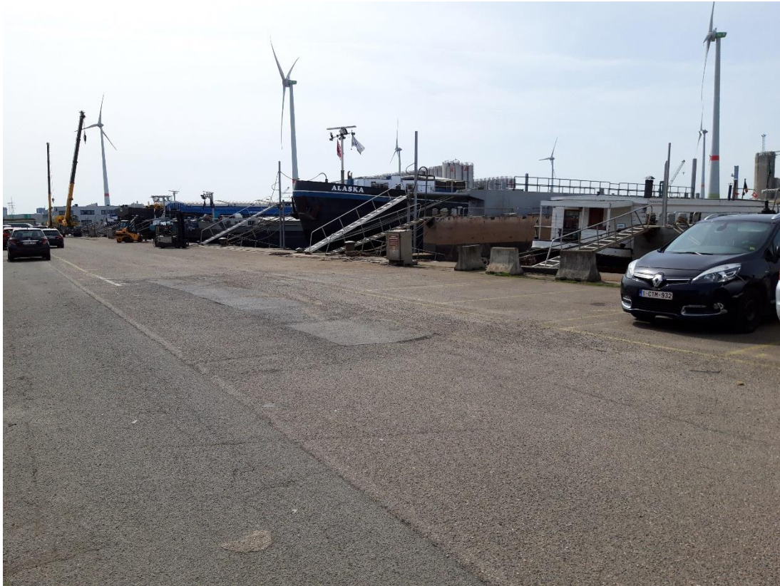
Foto 1: Foto van de geasfalteerde sporen van de (naar de Rijnkaai overgebrachte) elektrische kraan nr. 347 IA aan de Vosseschijsstraat zonder nummer, 12.04.2022 (bron: archief Onroerend Erfgoed, foto genomen door Martijn Kivit)
