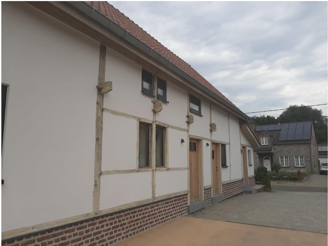
Foto 5: De erfgevel van het woonhuis.
