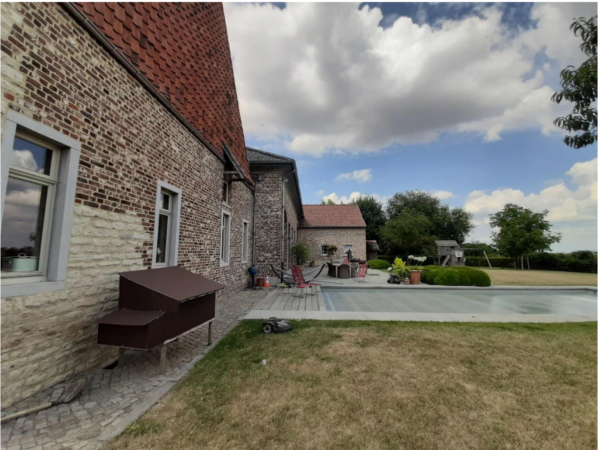
Foto 5: Achterzijde van hoeve Fouyn. Uiterst links het woonhuis met aanpalend de voormalige schuren.
