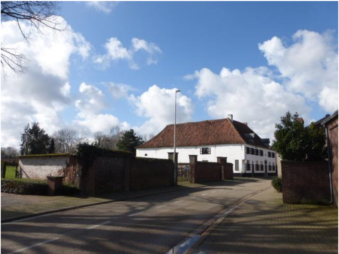
Foto 1: Resterende omheiningmuur aan de Maasstraat en naastgelegen woning Reynders (Agentschap OE)
