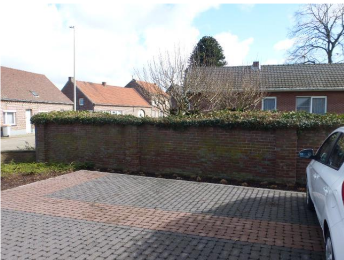
Foto 11: Heraangelegde parking en niet originele omheiningsmuur (Agentschap OE)
