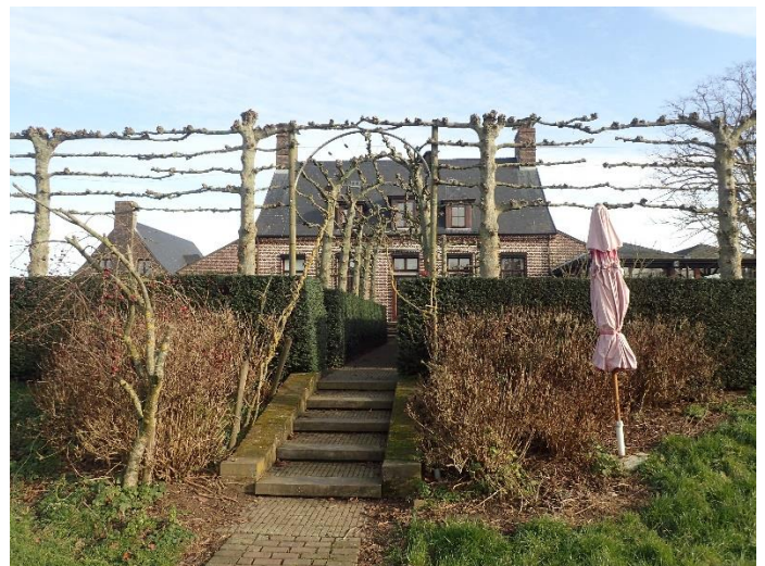
Foto 8: Achtergevel of westelijke gevel – tuin achteraan met recente berceau van lindes (na 2001) (10.02.2023)
