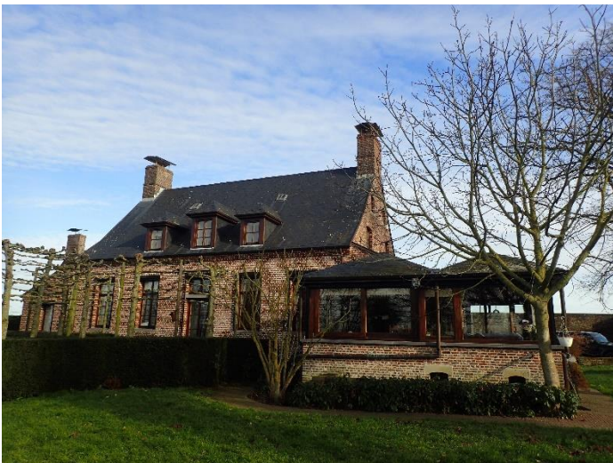
Foto 7: Aanbouw serre tegen de linker of zuidelijke zijgevel – westelijke achtergevel (10.02.2023)
