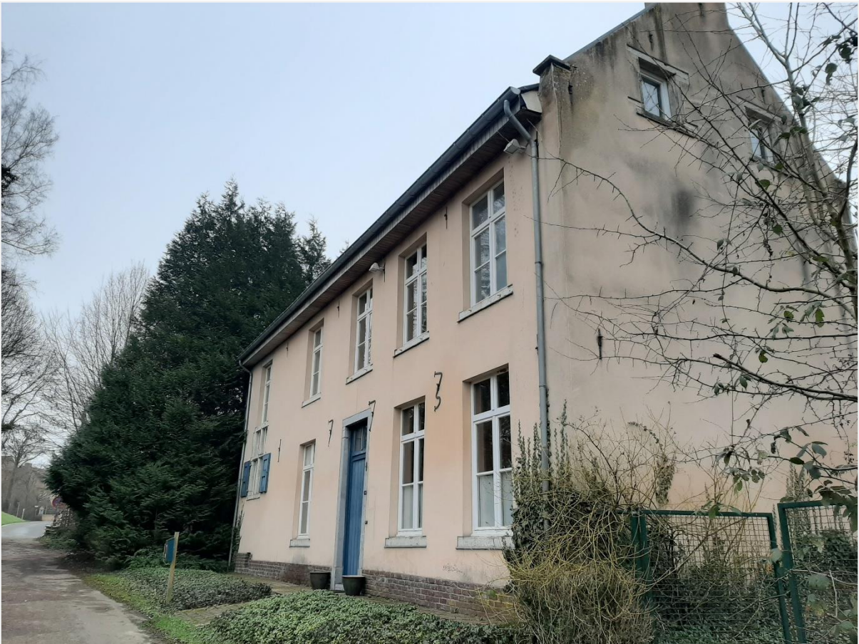
Foto 5: De afspanning De Drie Haringhe bevond zich oorspronkelijk aan de linkerzijde van dit woonhuis uit 1773.
