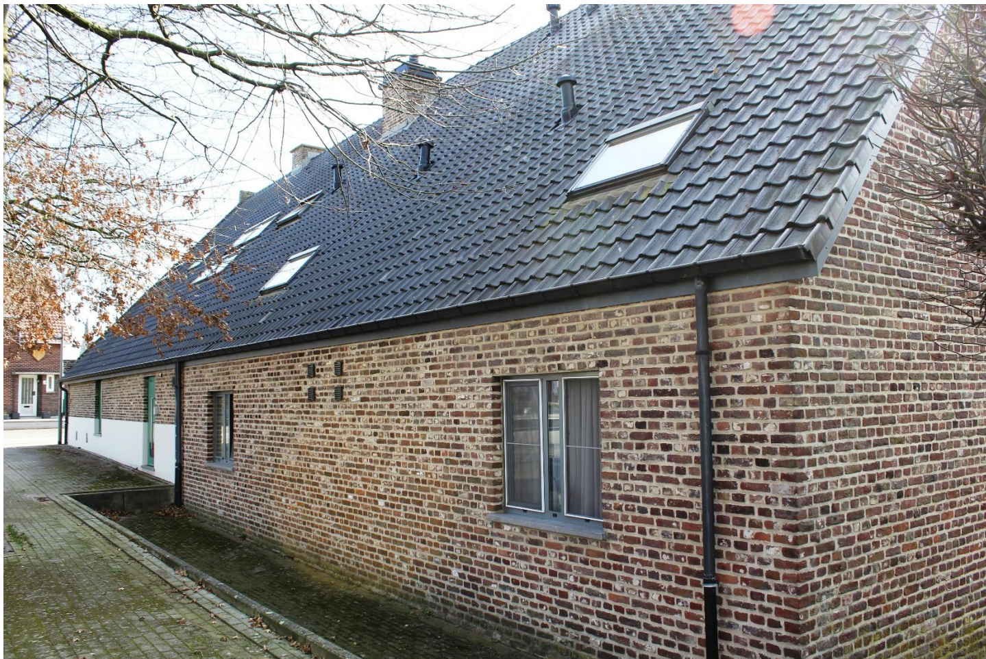
Foto 3: achtergevel van de noordvleugel van de hoeve De Licht (13 maart 2022)
