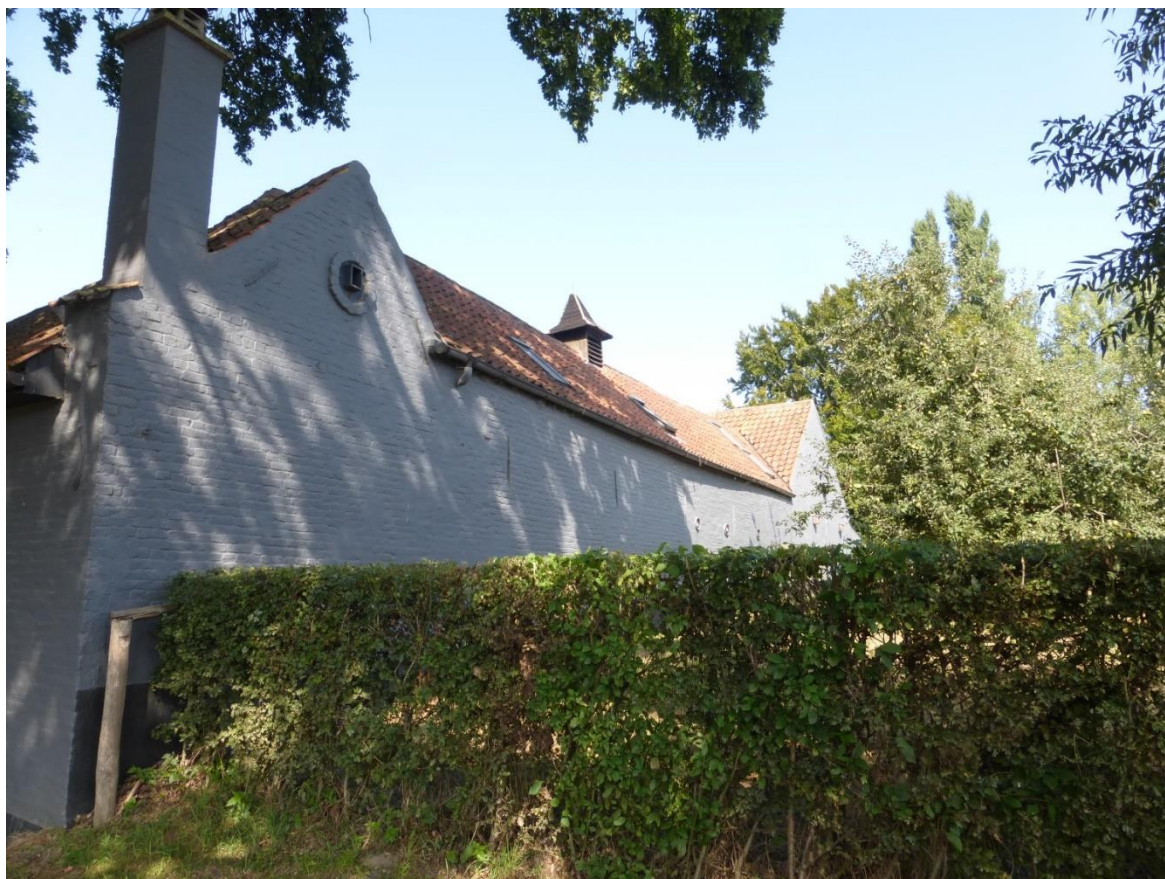
Foto 5. Blinde achtergevel van het woongedeelte (oostvleugel), geflankeerd door de zijpuntgevels met oculi van de zijvleugels. Dakruiter centraal op de nok van het dak. Recent grijs geschilderde baksteenbouw boven gepekte plint.
