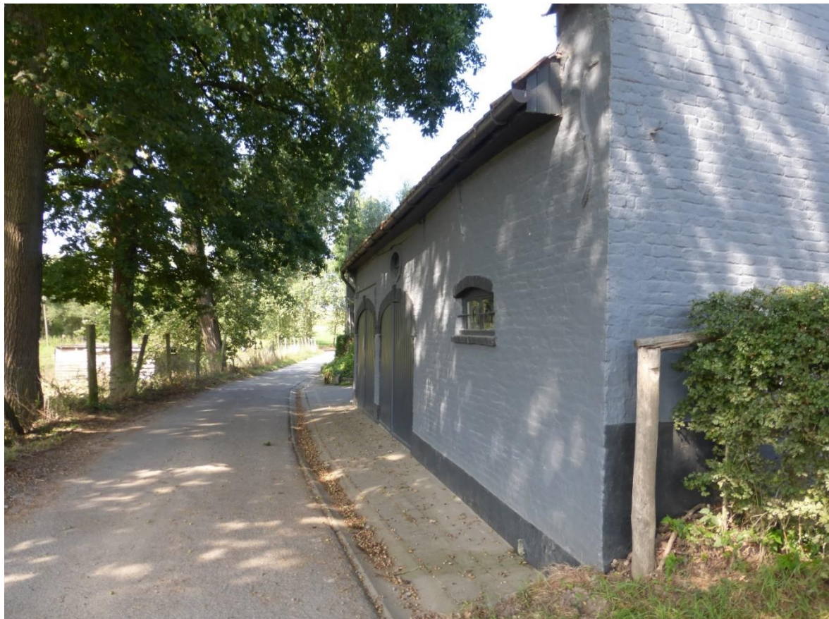
Foto 2. Zuidvleugel (vroeger schuurtje) met twee korfbogige garages aan de straatzijde (vanuit het oosten). Recent grijs geschilderde baksteenbouw boven gepekte plint. Oude eiken aan de overzijde van de straat.
