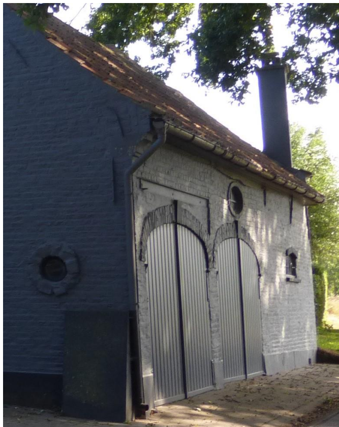
Foto 3. Bouwsporen getuigen ervan dat de zuidvleugel (straatzijde) het vroegere schuurtje was. Boven de linker korfboogpoort steekt een metalen latei van een vroegere rechthoekige, lage poort. Het metselwerk van de centrale travée (met poort en daarboven oculus) vervangt de oorspronkelijke, hoge schuurpoort. Onder de dakoverstek steekt nog de houten latei.
