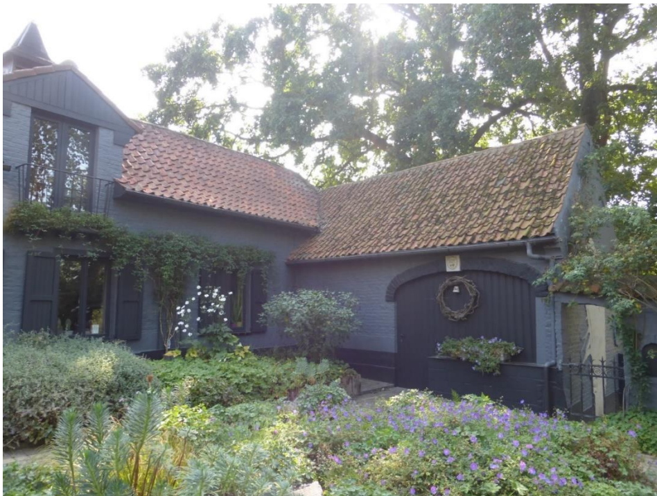
Foto 4. Het binnenerf van de hoeve in U-vorm is omgevormd tot siertuin. Centraal in het dak van het woongedeelte (oostvleugel) steken het dakvenster en de dakruiter. Recent grijs geschilderde baksteenbouw boven gepekte plint.
