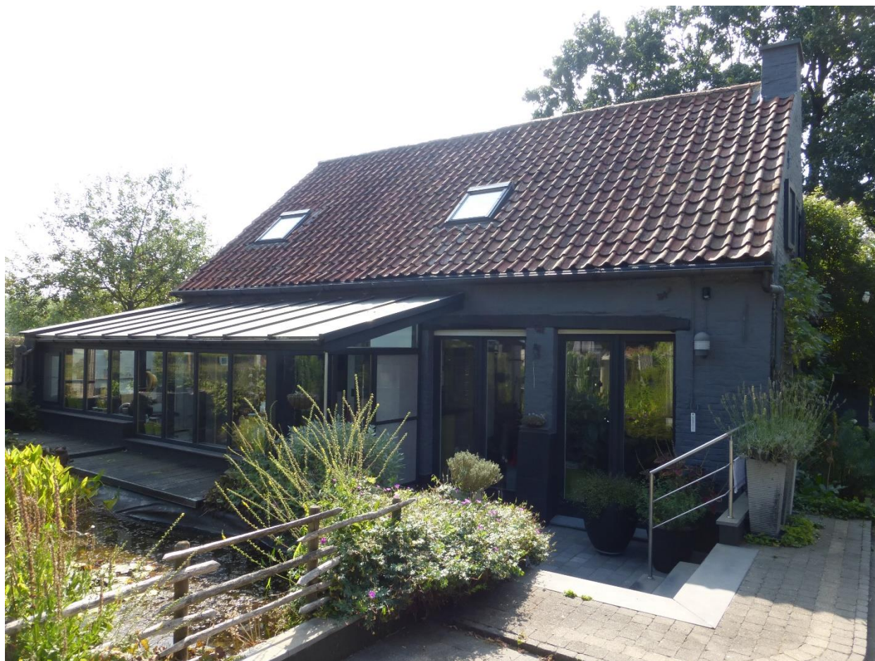
Foto 6. Achterkant van de noordvleugel met grote muuropeningen en aangebouwde veranda.
