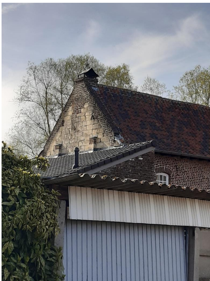
Foto 3 - Zicht op de noordelijke topgevel van de voormalige 'leerlooiërij' (© Onroerend Erfgoed).
