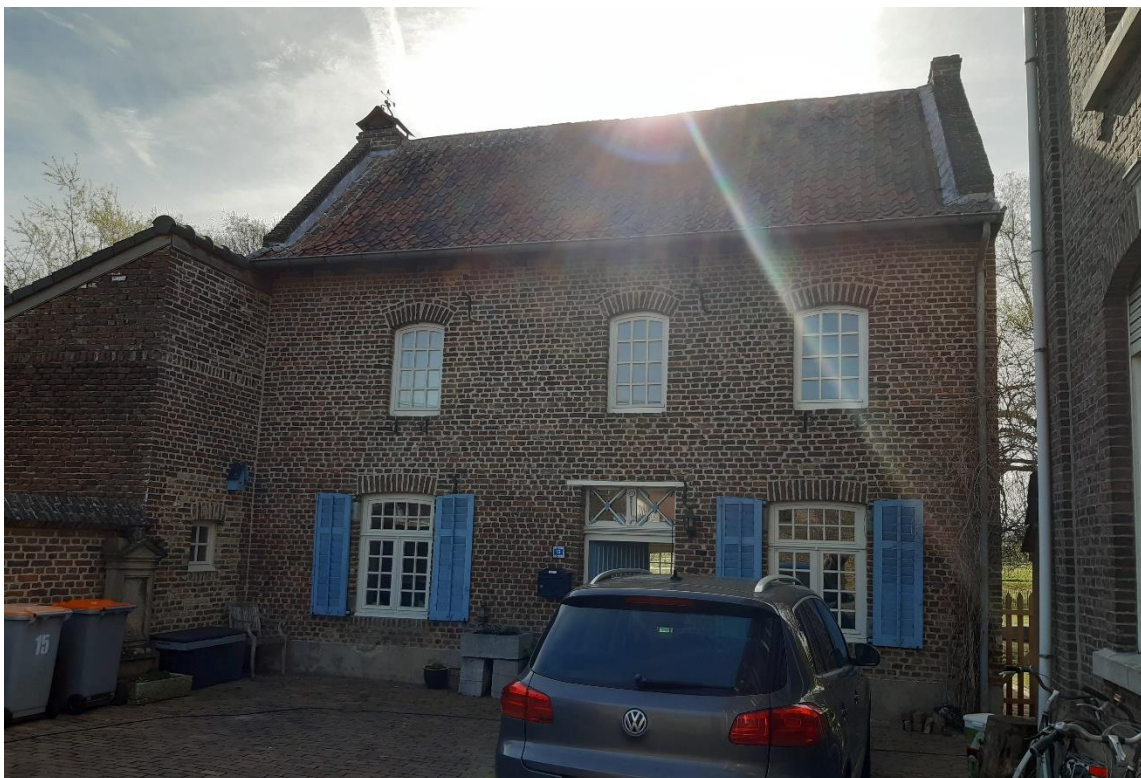
Foto 1 – Zicht op de west- of voorgevel van de voormalige 'leerlooiërij' (© Onroerend Erfgoed).
