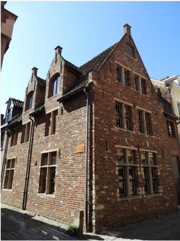
Foto 1: gevel Plotersgracht - Karmelietenstraat
