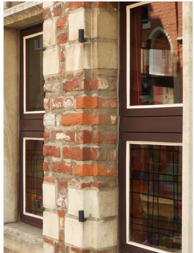
Foto 4: machinale afwerking van de dagkanten van de vensters
