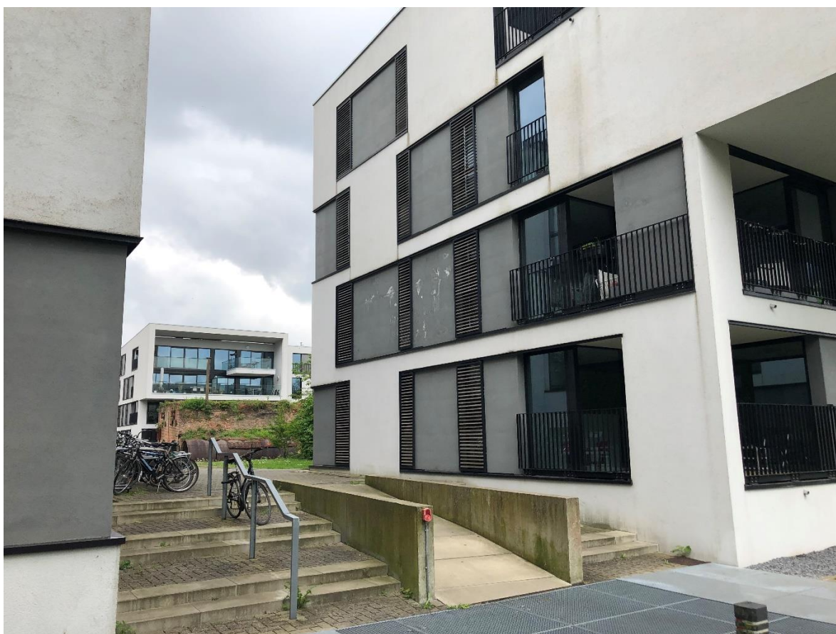
Foto 8 - Zicht op de appartementsgebouwen ten zuiden van het ketelhuis van de site Alsberge-Van Oost (© Onroerend Erfgoed – Leen Meganck).
