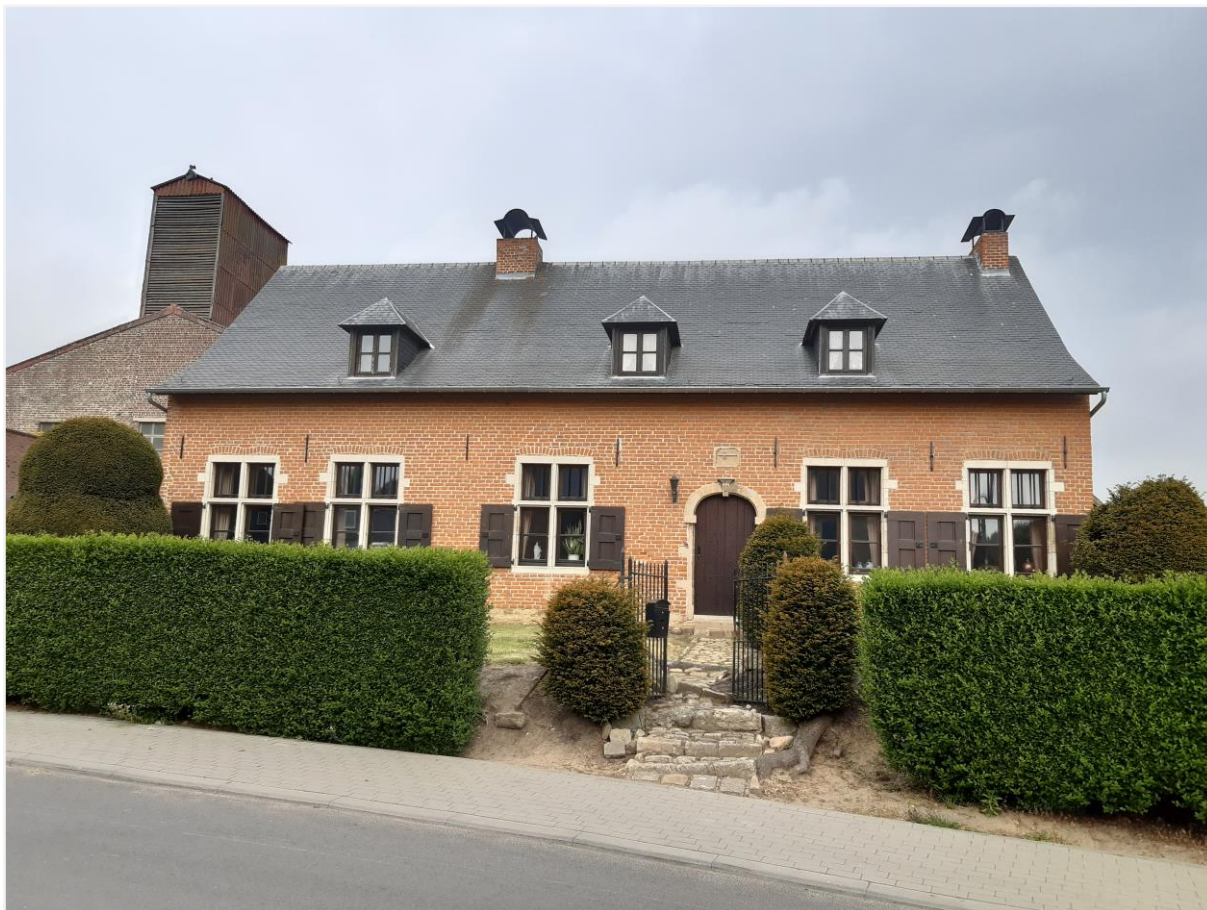
Foto 1: Zuidoostelijke voorgevel Herberg In Het Canon in Vossem. Zicht vanop het Dorpsplein ten noorden van de Sint-Pauluskerk.
