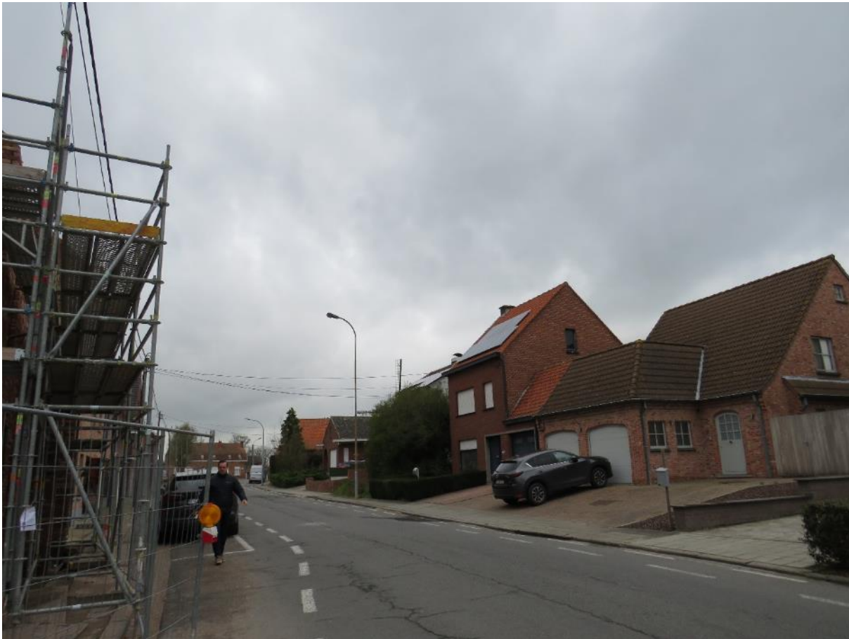
Foto 7 – Zicht op de Ma Campagnemolen vanuit de Oude Mesenweg (in het oosten).
