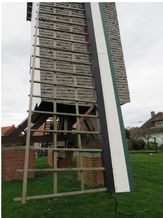
Foto 35 – Hekwerk van het gevlucht.
