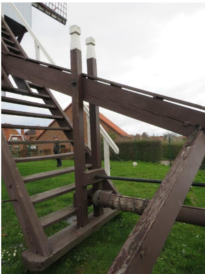
Foto 29 – Molentrap en staartbalk met kruiwerk.
