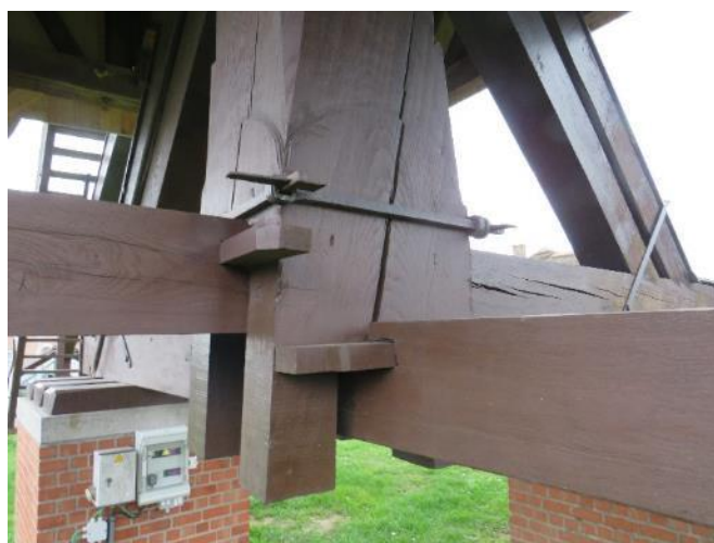
Foto 24 – De door kruisplaten gedragen standaard.
