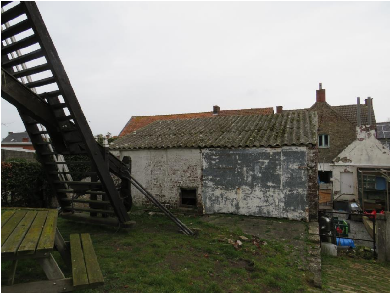
Foto 5 - Zicht vanop de molenbelt van de Kruisstraatmolen in noordoostelijke richting.
