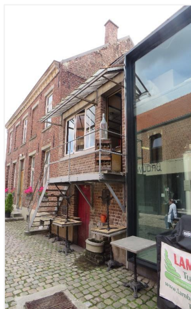
Foto 16: Het kantoorgebouw, erfgevel (06.10.2021).
