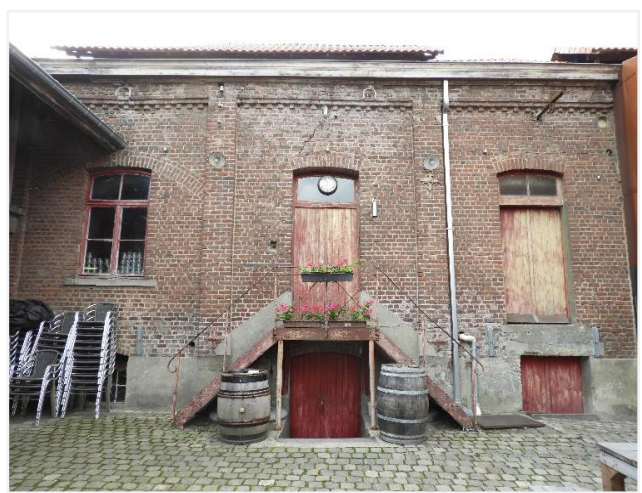
Foto 8: Het brouwerijgebouw, erfgevel (09.09.2019).
