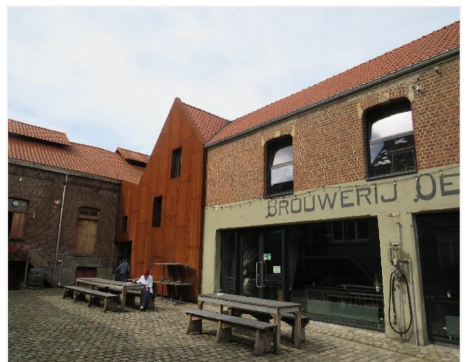
Foto 10: De hoek van het brouwerijgebouw en de noordvleugel, erfzijde (09.09.2019).
