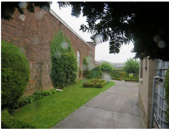
Foto 7: Het brouwerijgebouw, westgevel (06.10.2021)
