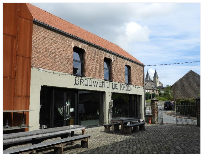
Foto 12: De noordvleugel vanuit het zuidwesten, erfgevel (09.09.2019).
