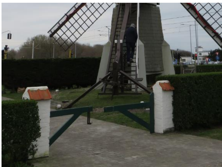
Foto 36 - Hubertmolen. Hek met baksten pilasters.
