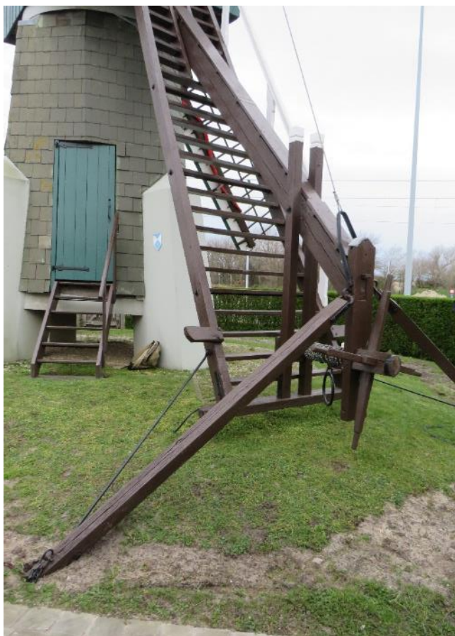
Foto 21 - Hubertmolen. Staart met molentrap en kruiwerk.
