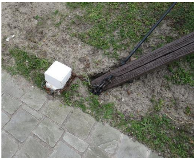
Foto 35 - Hubertmolen. Loopstaak vastgemaakt aan één van de kruipalen.
